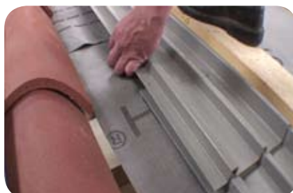
Les éléments s'emboîtent par recouvrement.
