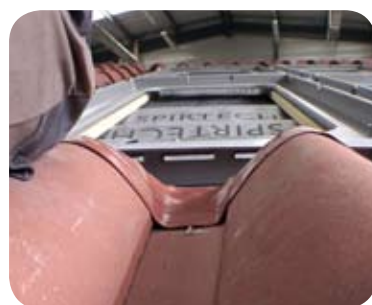
Grille de ventilation.
